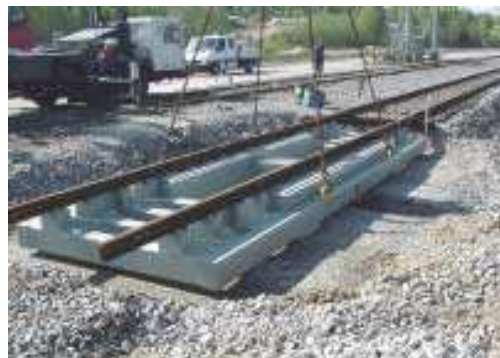
Montáž s kompaktním ocelovým rámem
